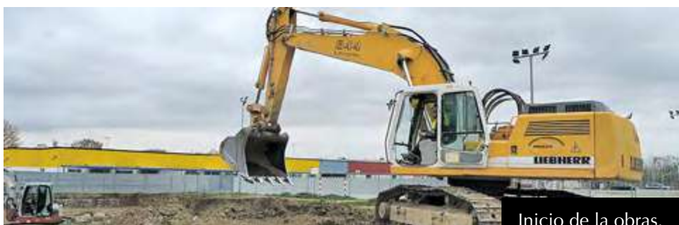
Inicio de la obras.
